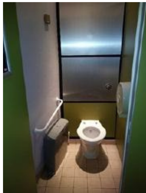
AMBULANT TOILET CUBICLE
